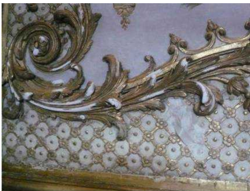
Ragréage de la réparation au blanc de Meudon sur les lacunes avant la pose du bol d'Arménie destiné à recevoir la dorure.
