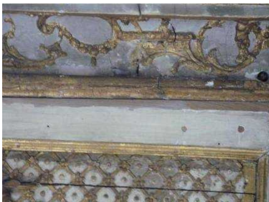
Rééquilibrage du chambranle de la porte par un flipot.
