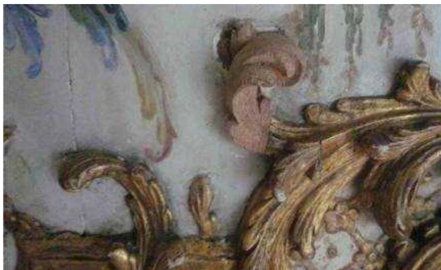
Réfection en chêne d'un élément sculpté de baguette d'encadrement. Une réparation au blanc de Meudon viendra ensuite recouvrir le motif. Le bol sera posé ensuite pour recevoir la feuille d'or.
