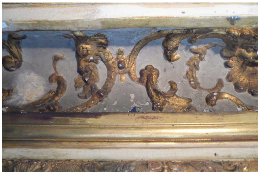
De nombreux désordres : empoussièrement, salissures, écaillages altéraient la corniche avant restauration.
