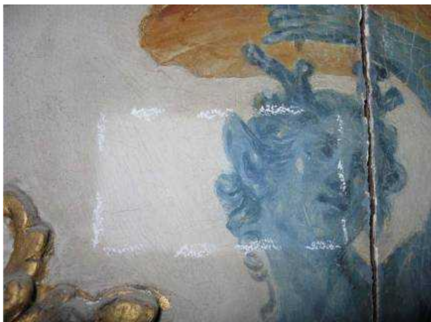
Test de décrassage sur un lambris de hauteur. Le fond blanc craquelé est un rechampi du XIX e venu détourner soigneusement la figure originale. Cette reprise, de qualité et de tonalité similaire a été conservée.
