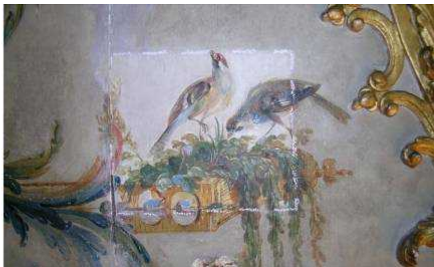
Autre sondage sur un lambris. L'éclaircissement est important et suffit à remettre en valeur les motifs par contraste. En bas sur le cliché on distingue une lacune dans le motif sculpté des baguettes dorées d'encadrement.
