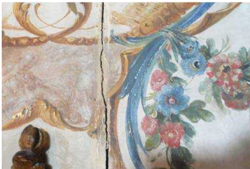
Certains mastics de comblement des fentes avaient parfois comme ici été expulsés par le retrait du bois au cours du temps.
