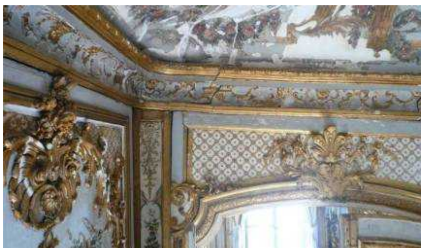
Nettoyage en cours du plafond et remplacement d'anciens rebouchages altérés.
