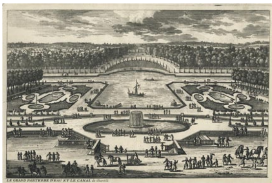
Le grand parterre d'eau et le canal de Chantilly
