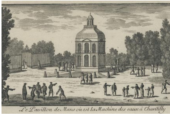
Le pavillon de Mans où est la Machine des eaux à Chantilly
